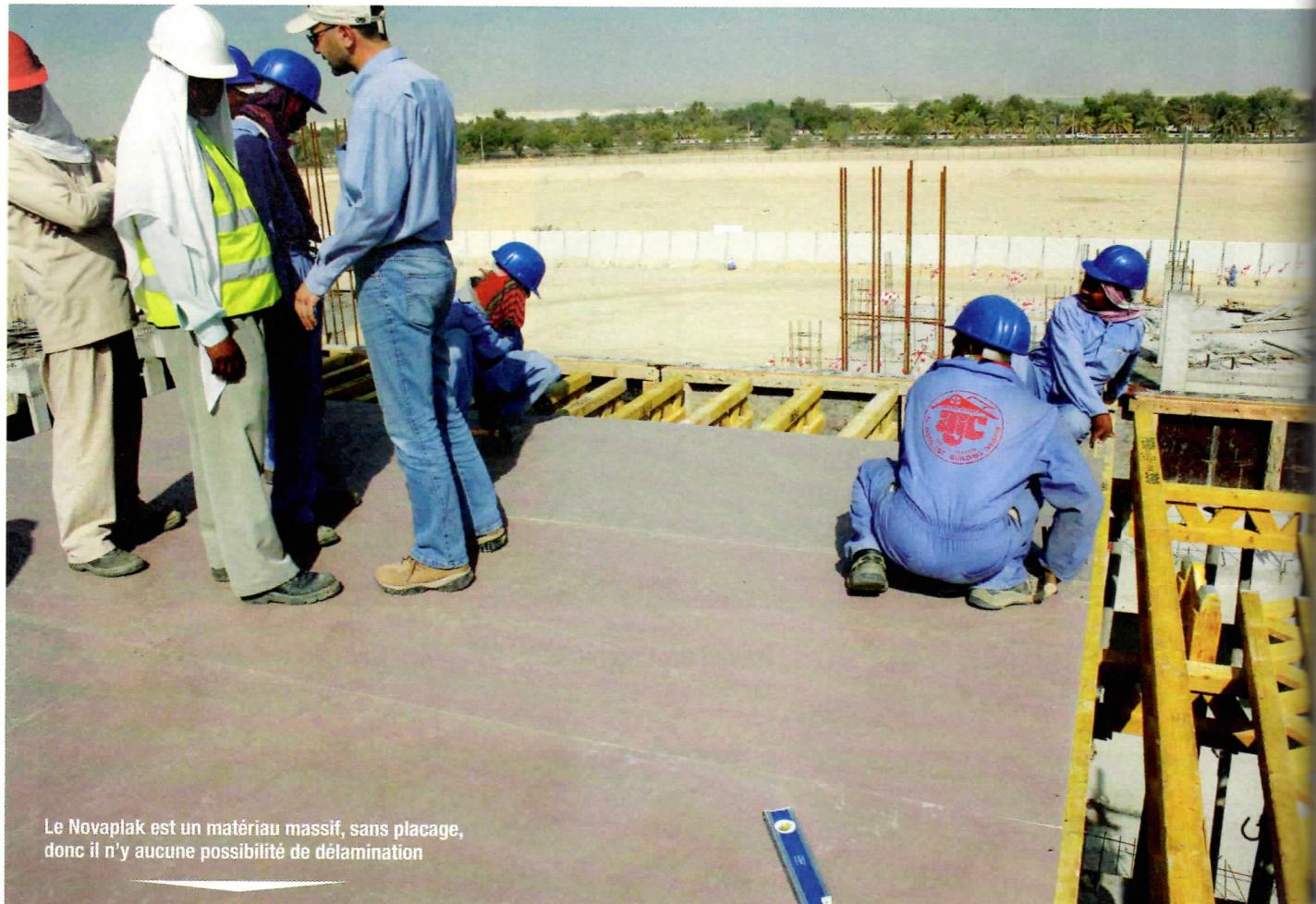
Le Novaplak est un matériau massif, sans placage, donc il n'y aucune possibilité de délamination
